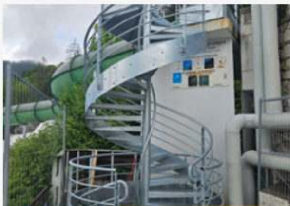
Remplacement de l'escalier hélicoïdal du toboggan.
