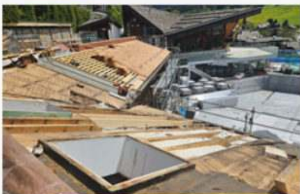
Réfection de l'avant-toit de la halle bassin en tavaillons.
