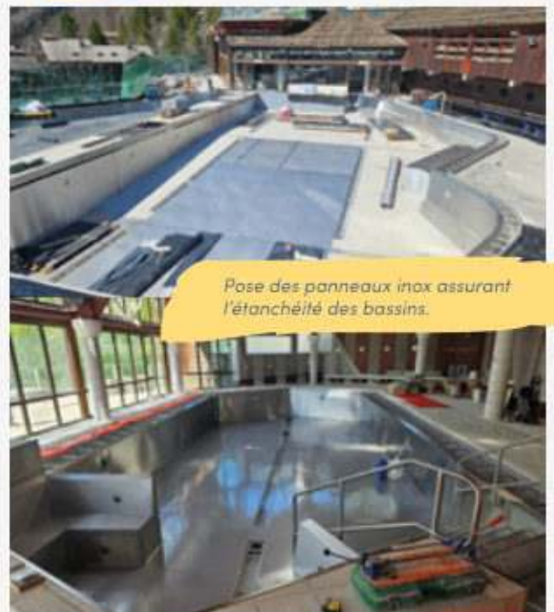
Démolition et curage des fonds de bassin pour retrouver le béton initial de 1967. Réparation et traitement des bétons pour assurer la pérennité de la structure.
