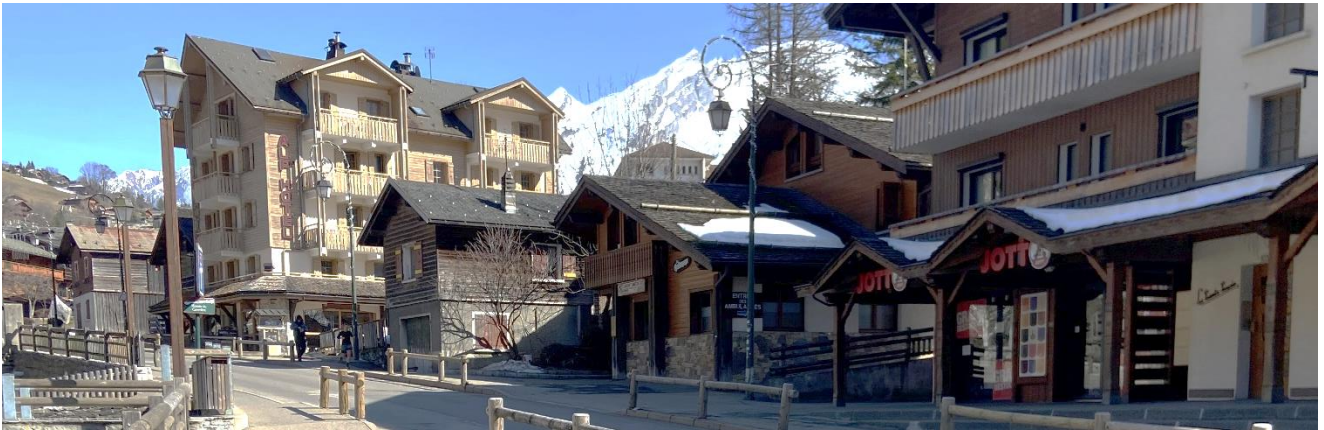
Photo 24. Des bâtiments de taille et d'aspects hétérogènes (Photo Mosaïque Environnement).
