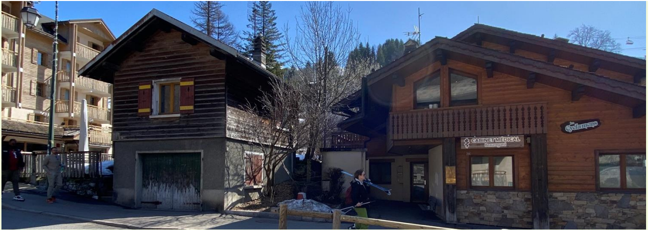
Photo 16. Façade Nord du petit bâtiment (Photo Mosaïque Environnement)
