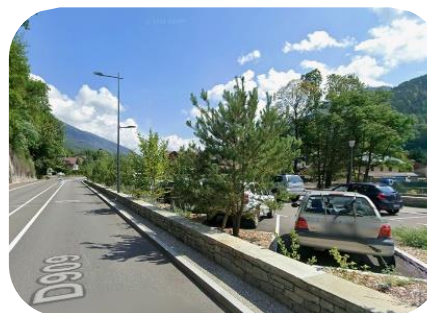
Parking de la gare routière de Thônes : intégration de diverses essences végétales et muret en pierres apparentes font la séparation avec la D909. A noter (non-visible) la mise en place d'une bordure de recharge VE
