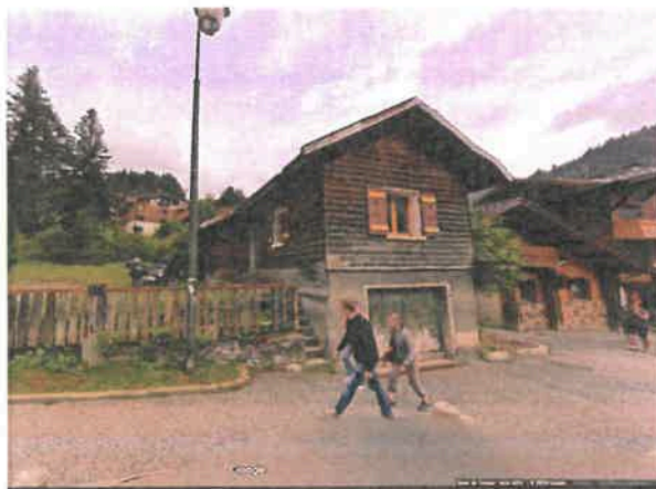
Photo 3 : Parcelle B 1873 route du Col des Aravis
