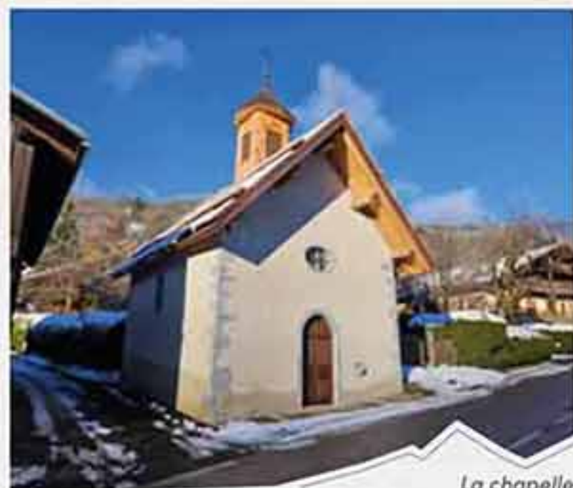
La chapelle rénovée en 2023
