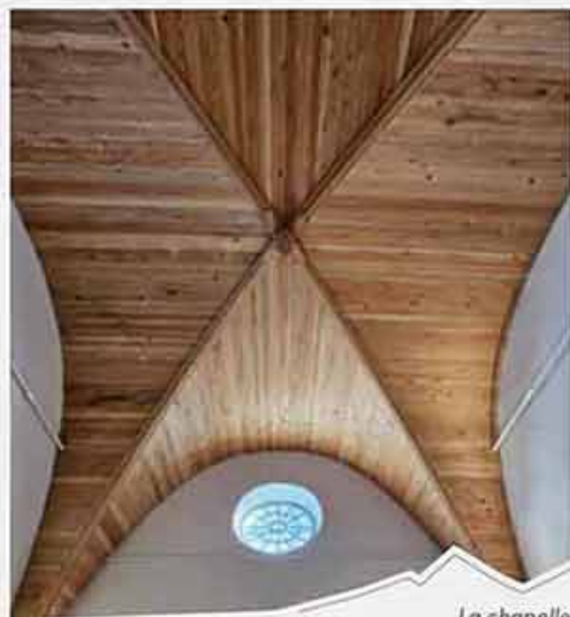
La chapelle rénovée en 2023
